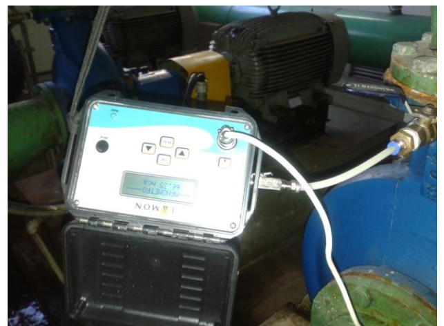
Fotografia 6. Medidor de pressão no recalque.
