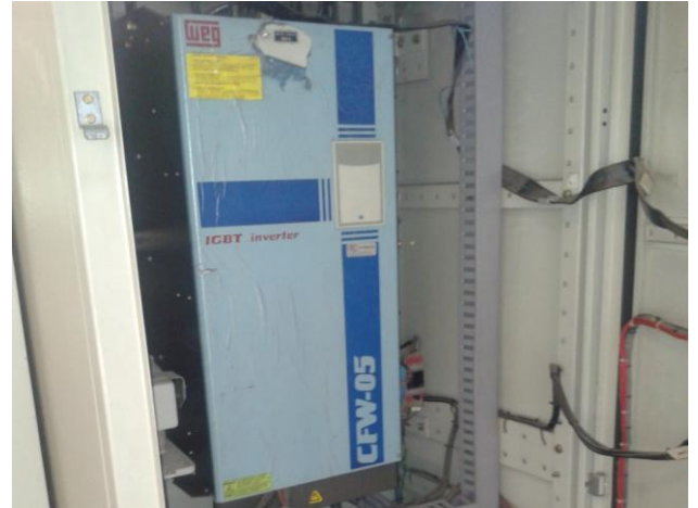
Fotografia 4. Inversor de frequência.
