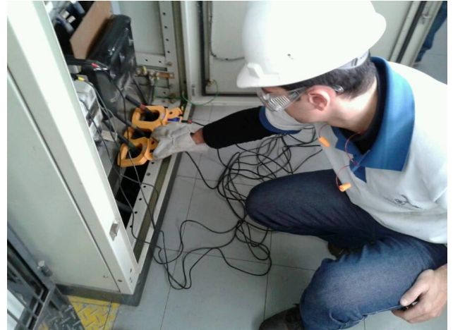
Fotografia 1. Instalação dos alicates amperímetro do analisador de energia.
